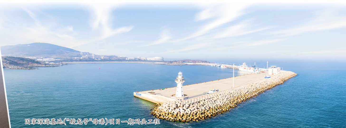
全球规模最大的自动化码头——上海国际航运中心洋山深水港四期工程
