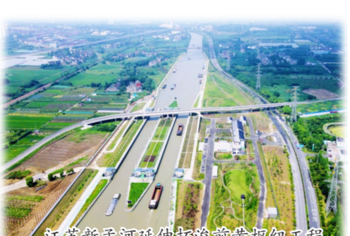
江苏新孟河延伸拓浚前黄枢纽工程
